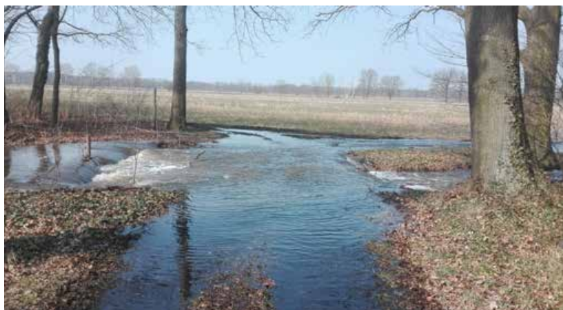
Dammbruch durch Bibergrabungen, Gefahr für Leib und Leben (Foto: A. Kittner)
